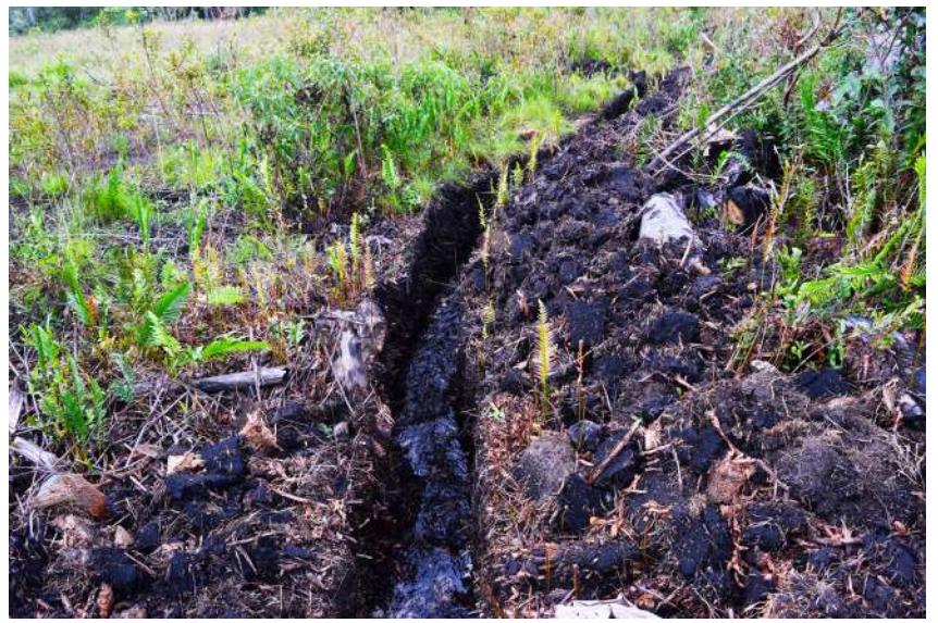
Regos das roças de esgoto
