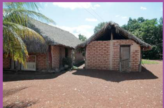
Casas de adobe e palha
